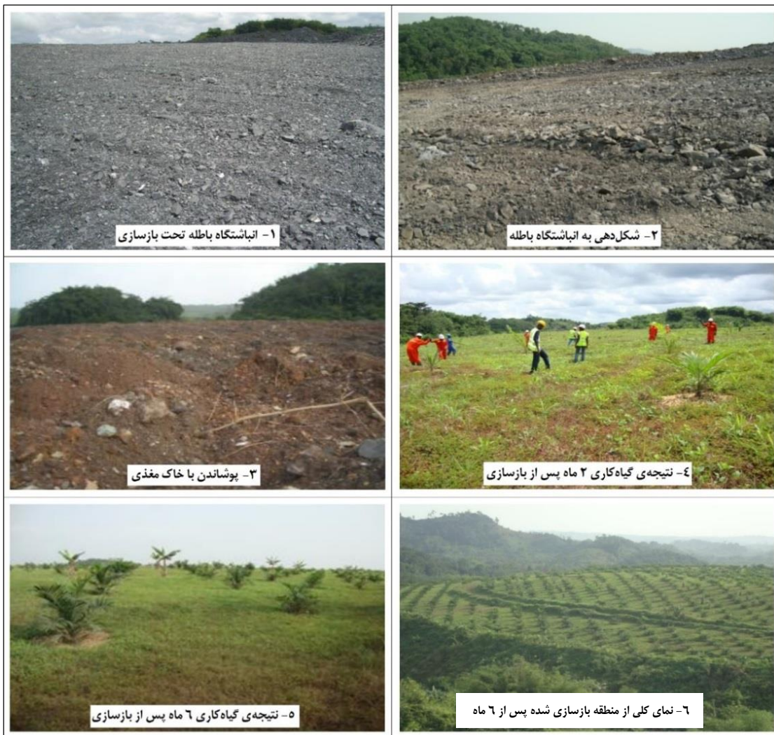
شکل ۳-۷- مراحل بازسازی انباشتگاه باطله
