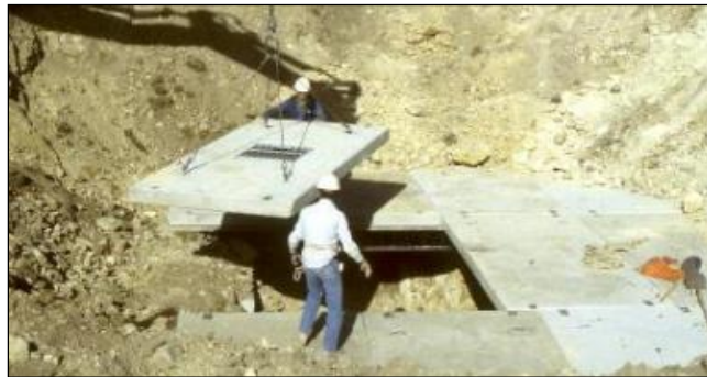
شکل ۲-۹- بستن چاه با سرپوش بتنی قابل برداشت
