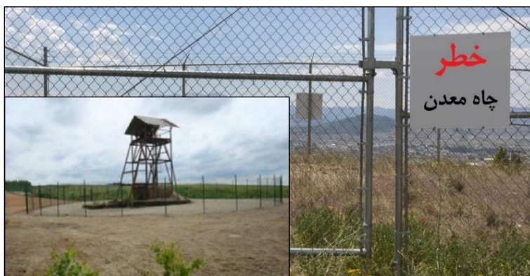
شکل ۲-۷- حصارکشی اطراف چاه معدنی
