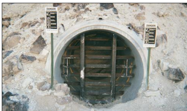
شکل ۲-۸- نمونه‌ای از دریچه فولادی برای جلوگیری از ورود احتمالی حیوانات کوچک
